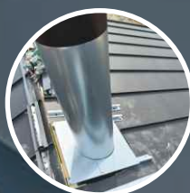
Vesikatolle tukilevyt pellityssarjan alle
