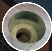
Isolering och plåtbrage för genomföring
