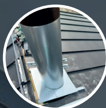
Stödplattor på yttertakets under plåtbeslaget
